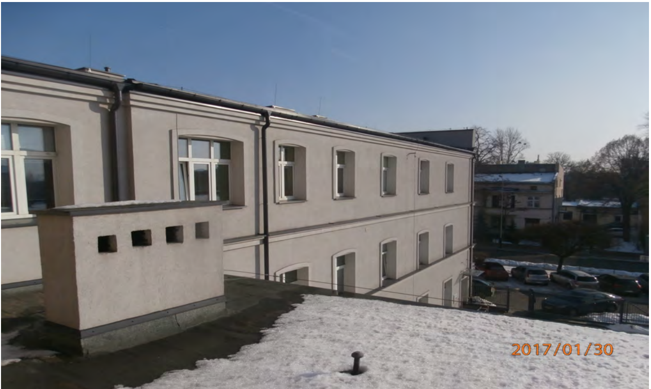
Fot.3. Widok budynku NR3 z dachu budynku NR2
