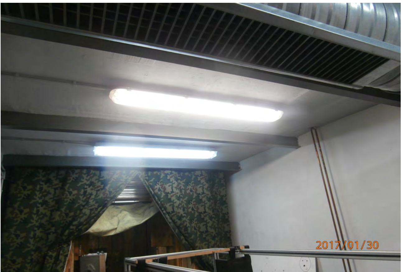
Fot.4. Widok stropu w laboratorium balistycznym Bud.4
