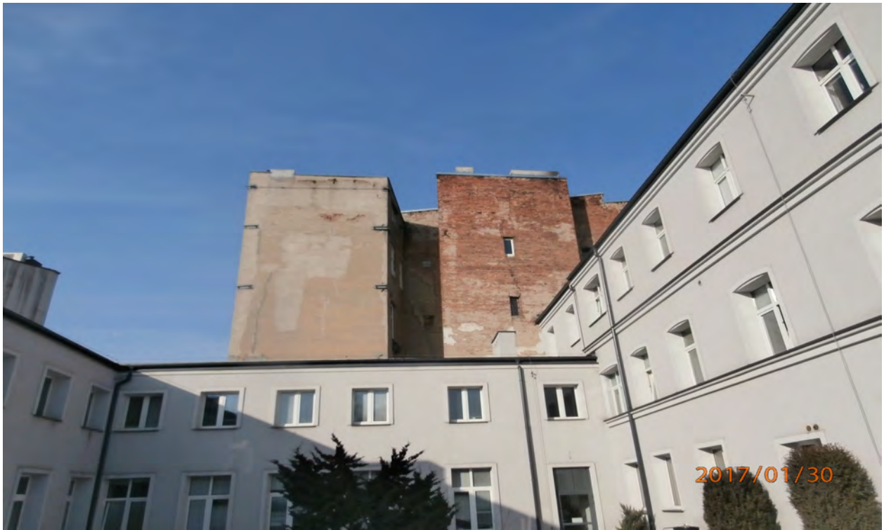
Fot.1. Widok elewacji, Bud. 2, 3
