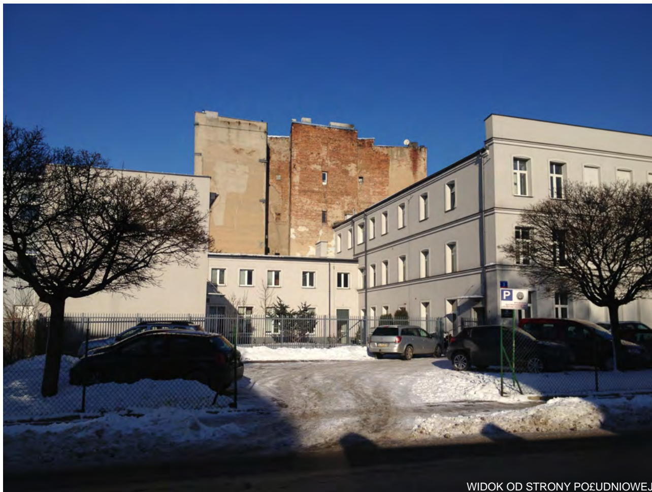
WIDOK OD POŁUDNIOWEGO - WSCHODU
